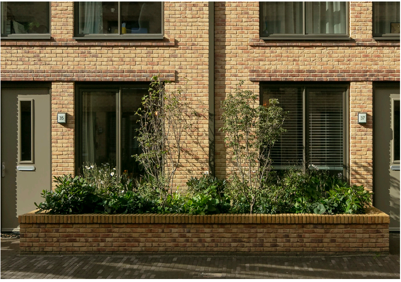
Plantenbakken - gemetselde plantenbakken in de margezone
