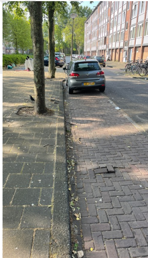
Afbeelding 10: Laanbeplanting aan de Sonderbuur met op verschillende plekken door boomwortels opgedrukte bestrating
