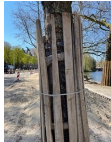
Afbeelding 31: Stambescherming biedt beperkte bescherming
