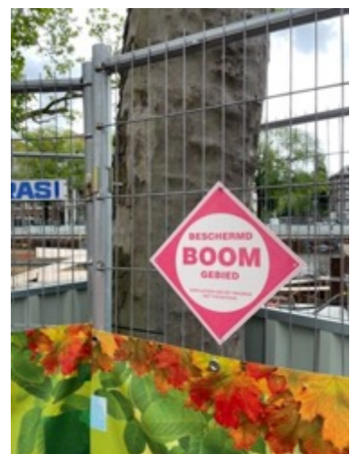
Afbeelding 32: Een vast hekwerk rond de groeiplaats (boomspeigel of plantvak) biedt betere bescherming.
