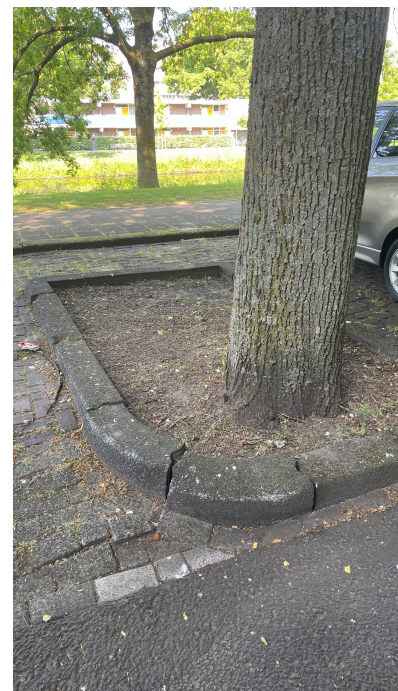
Afbeelding 24: Opedrukte opsluitband, met achter de boomspiegel overbodige verharding
